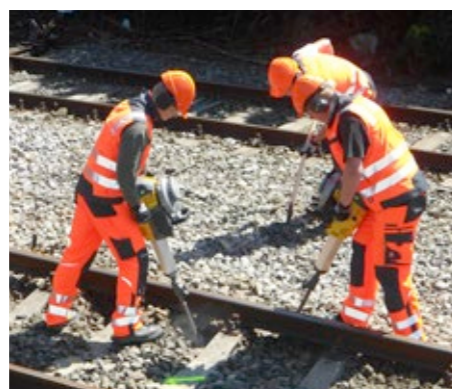
I martelli demolitori con motore a scoppio BH40 e BH55rw sono stati ottimizzati per i lavori di manutenzione nella posa dei binari.
