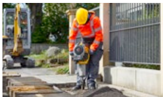
Tecnica di demolizione
